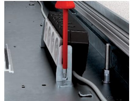
Montage Gerätebecher und Modulträger in Kanalunterteil Nach Anschluss der Installationsgeräte Geräteträger an Modulträger oder Gerätebecher montieren. Komplette Einheit im Kanalunterteil festschrauben.
