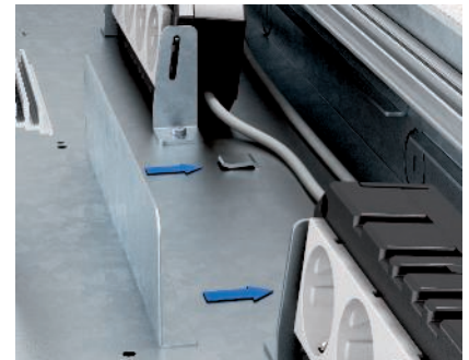
Montage Trennstege Trennstege erst nach Montage der fertig verdrahteten Gerätebecher und Modulträger einsetzen.
